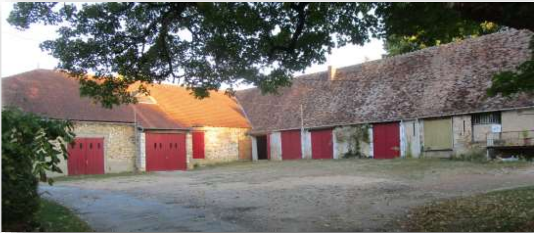
Bâtiments de la Basse cour utilisés par l'atelier d'artillerie
