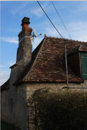
l'épi de faitage d'une maison de Nesmes route de Lignac
